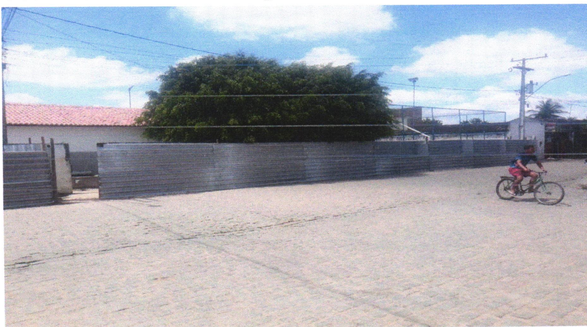
FOTO 02 - TAPUME COM TELHA METÁLICA. AF_05/2018
