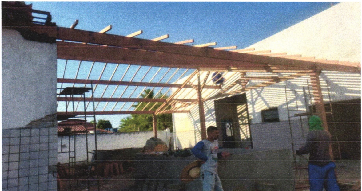
FOTO 24 - TRAMA DE MADEIRA COMPOSTA POR RIPAS, CAIBROS E TERÇAS PARA TELHADOS DE ATÉ 2 ÁGUAS PARA TELHA CERÂMICA CAPA-CANAL, INCLUSO TRANSPORTE VERTICAL. AF_07/2019
