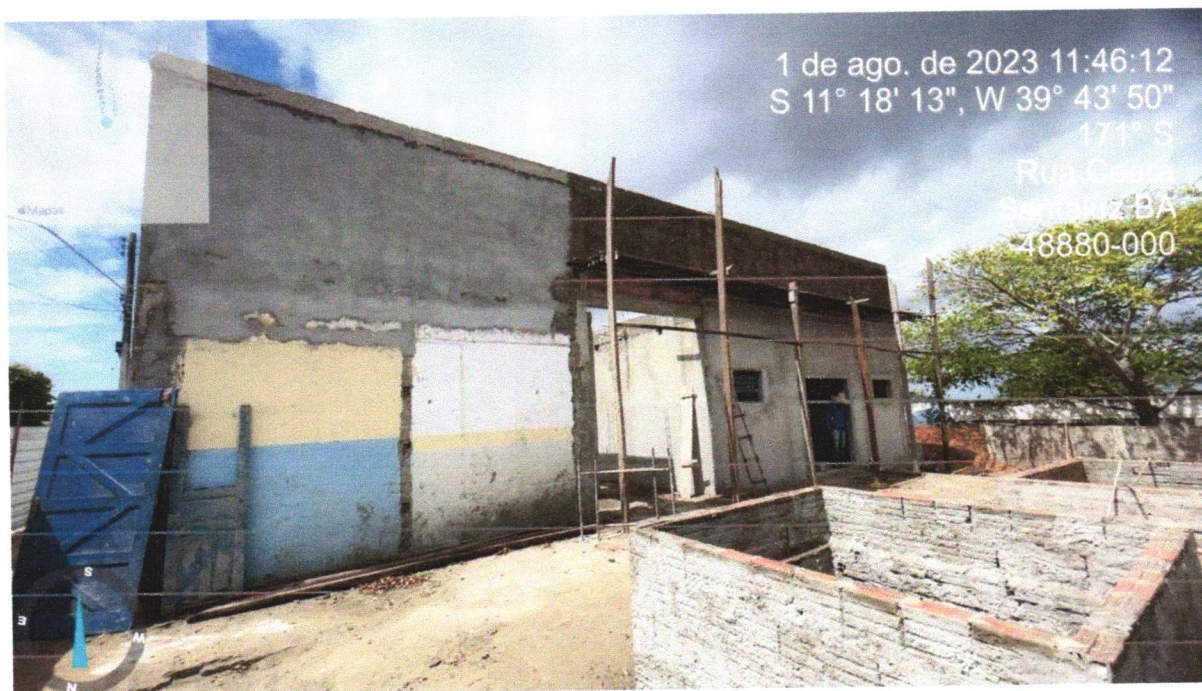
FOTO 04 - ALVENARIA DE VEDAÇÃO DE BLOCOS CERÂMICOS FURADOS NA HORIZONTAL DE 9X19X19CM (ESPESSURA 9CM) DE PAREDES COM ÁREA LÍQUIDA MAIOR OU IGUAL A 6M 2 SEM VÃOS E ARGAMASSA DE ASSENTAMENTO COM PREPARO EM BETONEIRA. AF_06/2014
