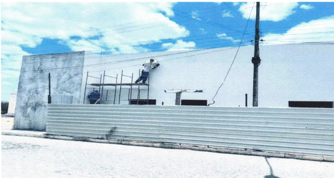
FOTO 32 - APLICAÇÃO E LIXAMENTO DE MASSA LÁTEX EM PAREDES, UMA DEMÃO. AF_06/2014
