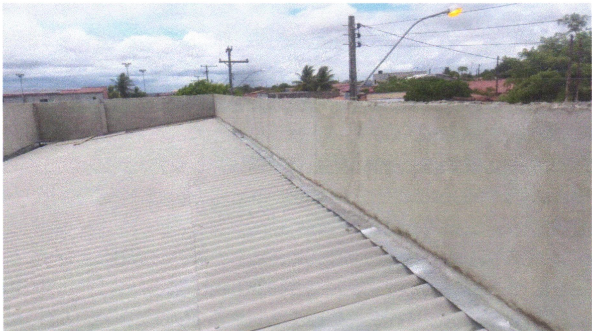
FOTO 28 - Rufo em chapa aço galvanizado nº24 com desenvolvimento 25cm
