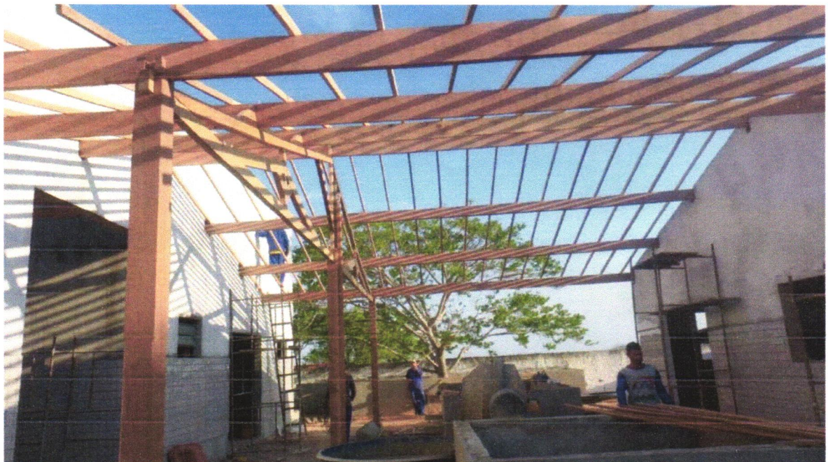
FOTO 24 - TRAMA DE MADEIRA COMPOSTA POR RIPAS, CAIBROS E TERÇAS PARA TELHADOS DE ATÉ 2 ÁGUAS PARA TELHA CERÂMICA CAPA-CANAL, INCLUSO TRANSPORTE VERTICAL. AF_07/2019
