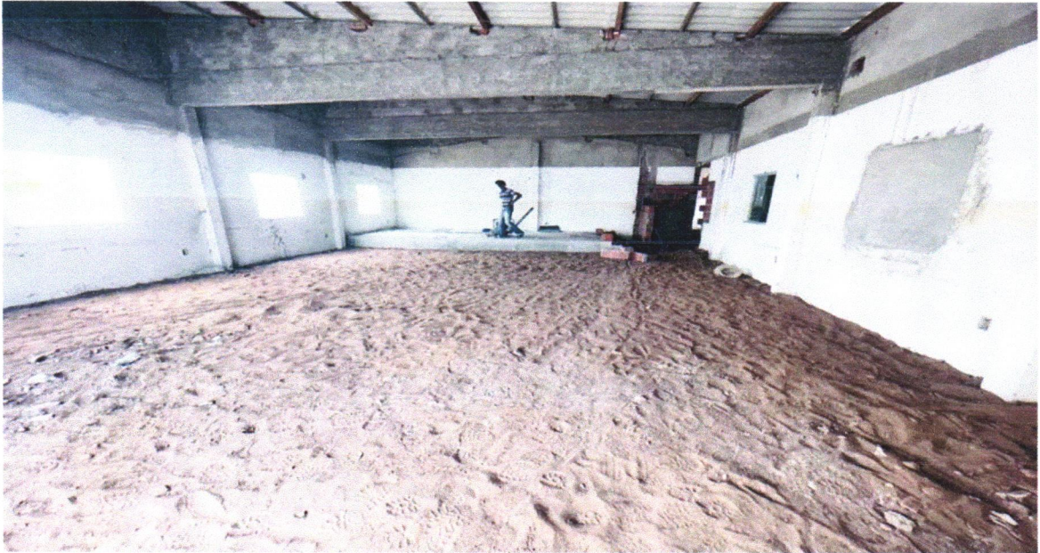
FOTO 30 - Preparo de superfície com lixamento de paredes e tetos
