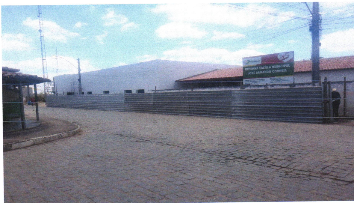
FOTO 02 - TAPUME COM TELHA METÁLICA. AF_05/2018
