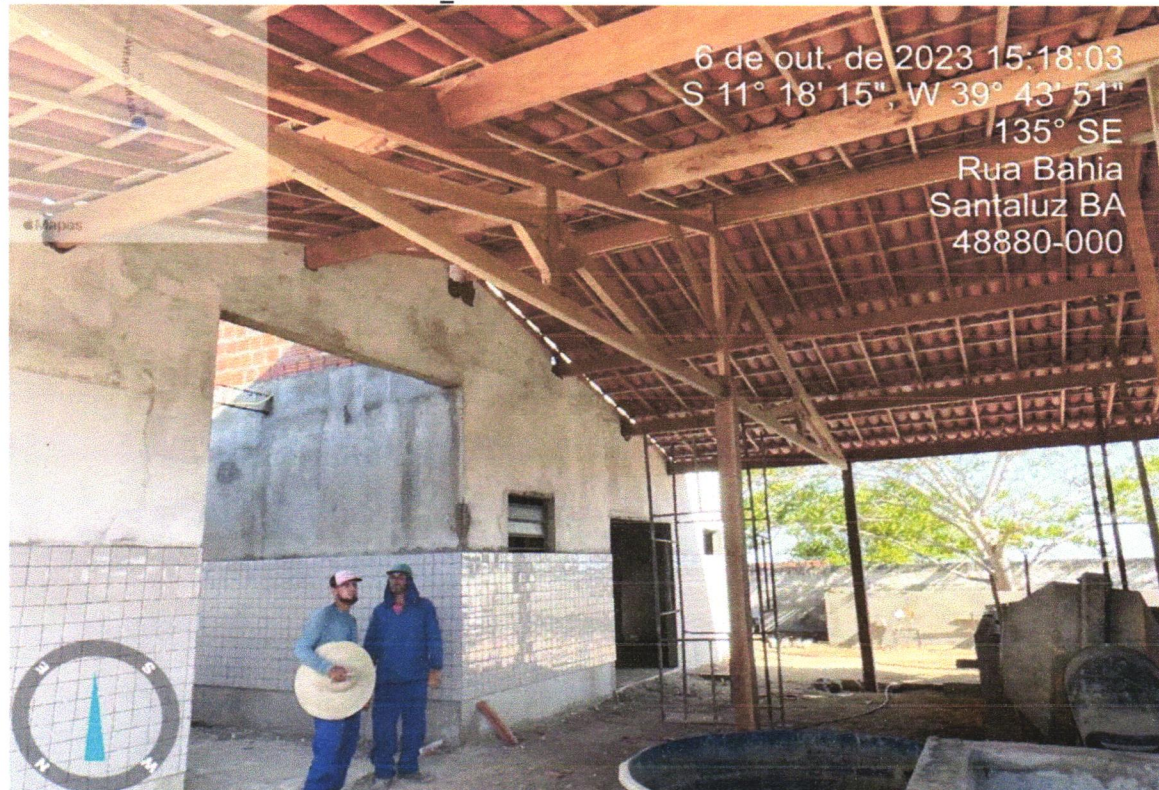
FOTO 22 - TELHAMENTO COM TELHA CERÂMICA CAPA-CANAL, TIPO COLONIAL, COM ATÉ 2 ÁGUAS, INCLUSO TRANSPORTE VERTICAL. AF_07/2019
