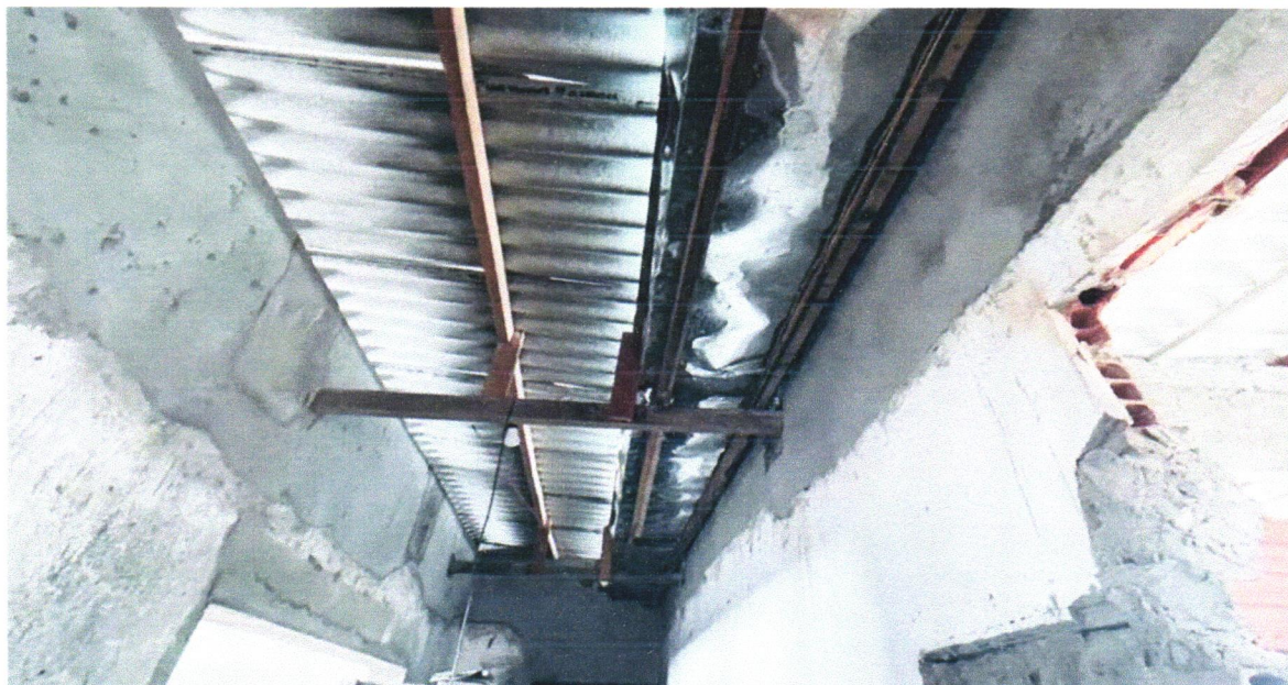
FOTO 26 - CALHA EM CHAPA DE AÇO GALVANIZADO NÚMERO 24, DESENVOLVIMENTO DE 50 CM, INCLUSO TRANSPORTE VERTICAL. AF_07/2019
