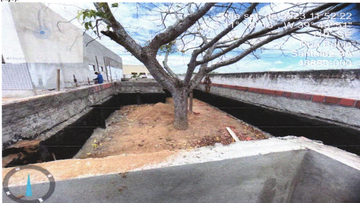
FOTO 18 - MASSA ÚNICA, PARA RECEBIMENTO DE PINTURA, EM ARGAMASSA TRAÇO 1:2:8, PREPARO MECÂNICO COM BETONEIRA 400L, APLICADA MANUALMENTE EM FACES INTERNAS DE PAREDES, ESPESSURA DE 10MM, COM EXECUÇÃO DE TALISCAS. AF_06/2014
