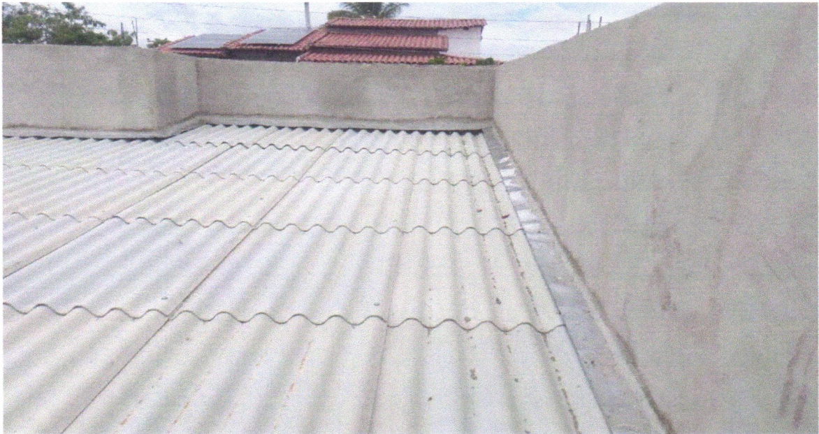
FOTO 28 - Rufo em chapa aço galvanizado nº24 com desenvolvimento 25cm
